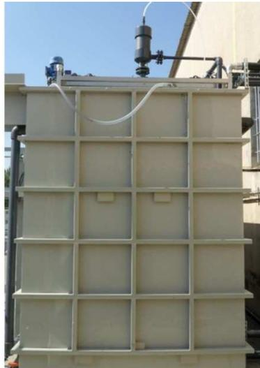
Las aguas ultrafiltradas llegan a un depósito anexo a la cuba de membranas, éste siempre está lleno, de modo que el vertido se produce por rebose de este depósito.
